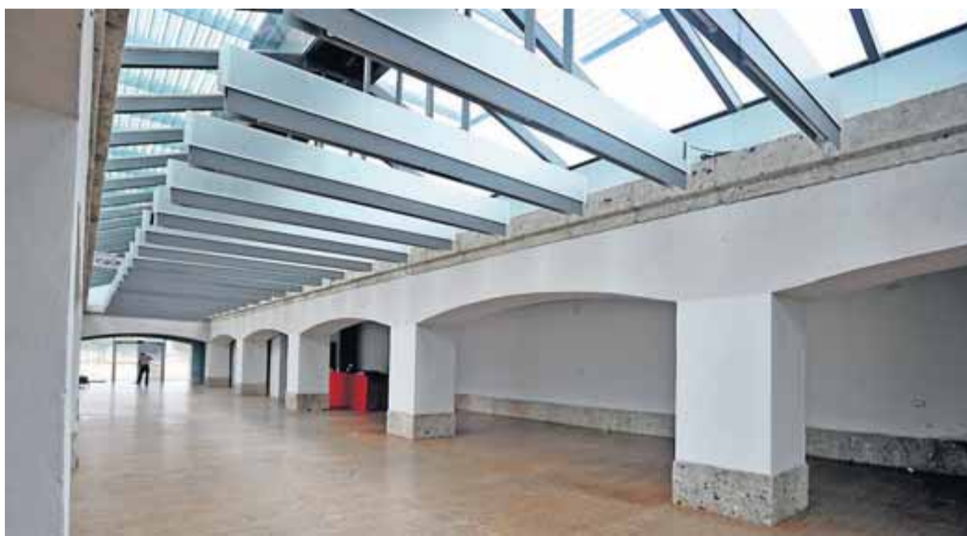
Der Kopfbau hat zwar keinen Keller und derzeit keine Heizung, dafür aber eine Menge Vorteile: Er eignet sich für Events, für Gastronomie, aber auch als Treff, zum Musikzieren oder etwa für Gymnastik. Und er ist aus Kirchtrudering oder Riem fast ebenso gut zu erreichen wie aus der Messestadt. FOTO: CLAUDIUS SCHUNK
